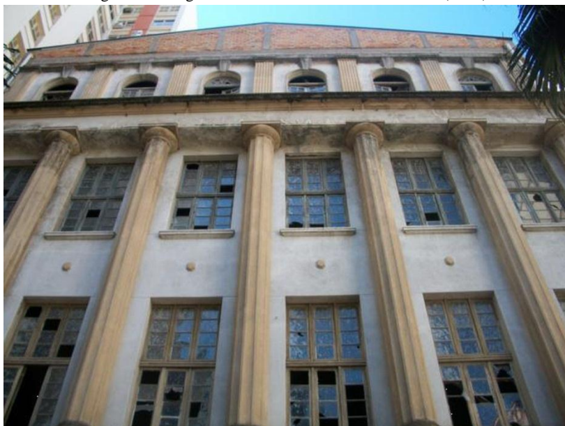
Figura 4 – Imagem da fachada do Ginásio das Dores (2012)
